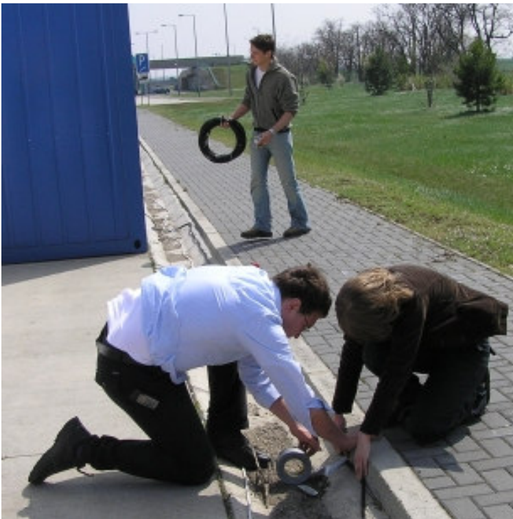
Abb.4 (links): (Quanten)mechaniker beim Installieren der Glasfasern an der slowakischen Grenze.
